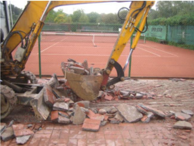
Im Oktober (nach Saisonende) wurde es laut vor dem Clubhaus. Nach und nach waren insgesamt drei Pressluftbohrer und zwei Bagger am werken. Die Bohrer rissen die Platten und den Betonuntergrund auf, die Bagger schafften den Schutt in bereitstehende Container - insgesamt wurden neun Container gefüllt und abgefahren.
