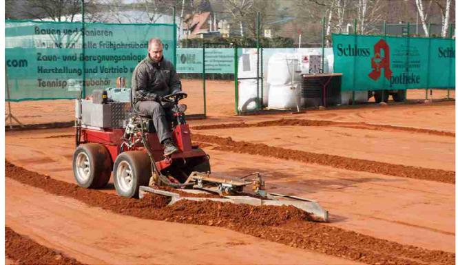
exakten Reihen aufgehäuft. Die nächste Maschine fährt diesen Häufchen entlang und saugt alles weg bis eine ganz glatte Oberfläche entsteht.
